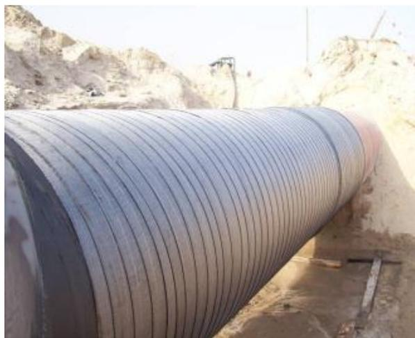
A **PETROENGE** possui parceria tecnológica com a empresa americana Polyguard, fabricante do revestimento anticorrosivo para tubos enterrados RD6, uma das soluções mais utilizados pela indústria de petróleo e petroquímica para a proteção de oleodutos, gasodutos, e outros tubos de uso subterrâneos.
